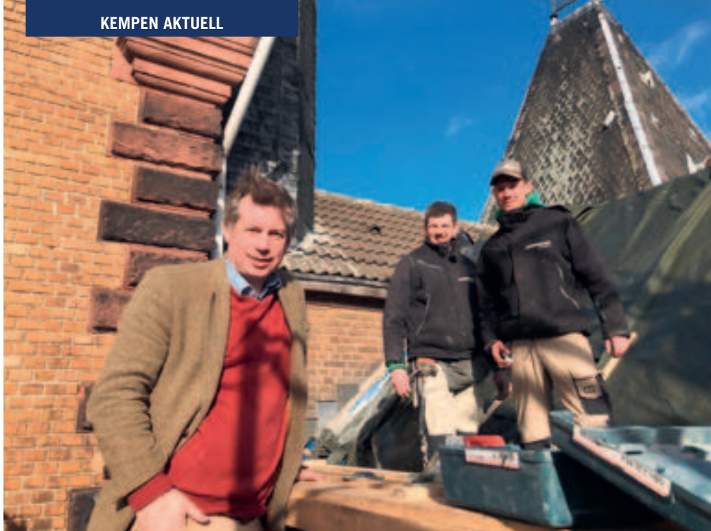
Das Herrenhaus im englischen Stil auf Gut Heimdahl (links und rechts unten) ist ein echter Blickfang. Hofherr Hannes von Heimendahl (oben) schaut, wie die Dacharbeiten voranschreiten, und freut sich über die breite Unterstützung (linke Seite) beim Erhalt des denkmalgeschützten Gebäude-Ensembles.
